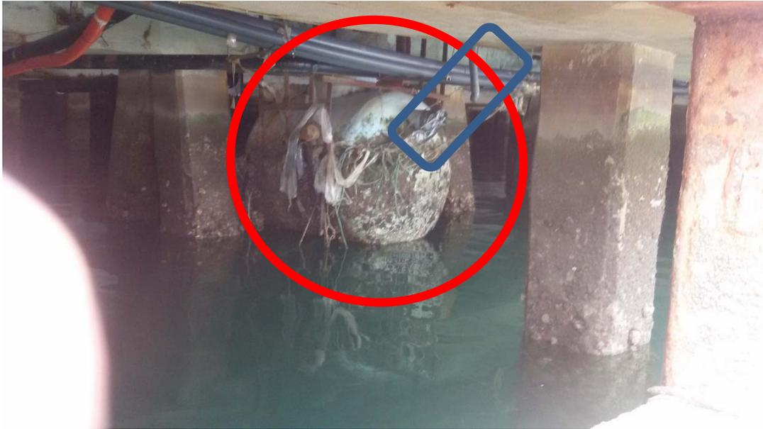
Foto 10. Tomada en 2017, desde el cantil en la cubierta de un pesquero y en bajamar. El separador de hidrocarburos (rojo) está sujeto por una estructura metálica a la losa a base de chapas. Obsérvese que la tubería de entrada (azul) ya se encuentra desenganchada del equipo.
