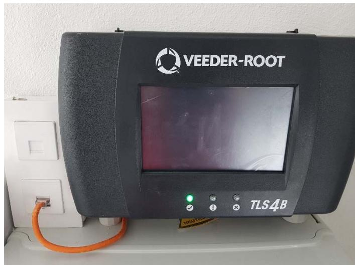
Foto 4. Consola de control Veeder-Root para control de las existencias de cada uno de los depósitos de combustible.
