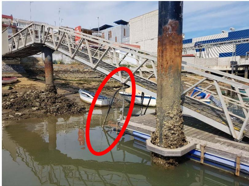
Foto 9. Tramos de tubería de combustible flexible que permiten acompasar la tubería de combustible con los movimientos del pantalán flotante ocasionados por la marea
