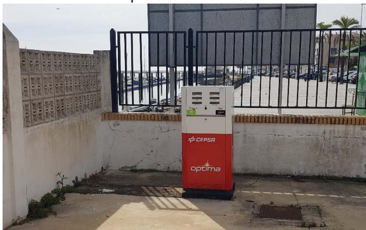
Foto 6. Medidor del volumen suministrado por los dispensadores, situado en la parcela junto a la entrada al pantalán
