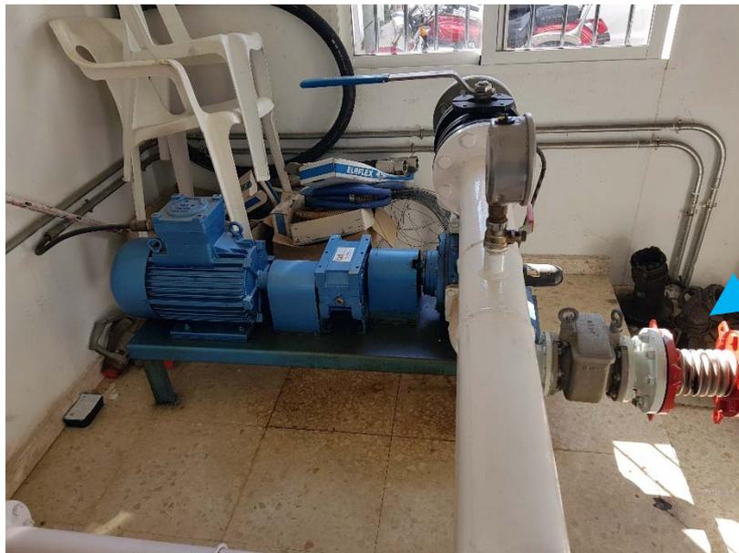
Foto 16. Ubicación del punto bajo en la caseta de bombas donde se colocará un sumidero comunicado con el separador de hidrocarburos
