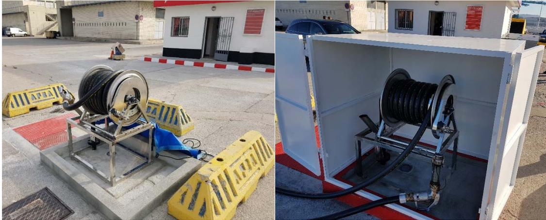
Fotos 2 y 3. Aspecto de una nueva devanadera sobre minicubeto de recogida de derrames y armario de protección.
