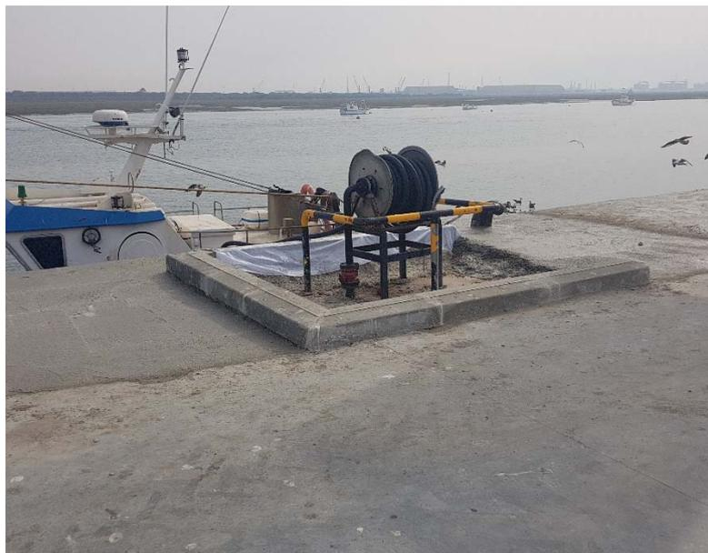
Foto 13. Minicubeto existente para la recogida de potenciales derrames de la devanadera, o de su manguera y boquerel. Se comunicará por el inferior de la losa con el separador de hidrocarburos
