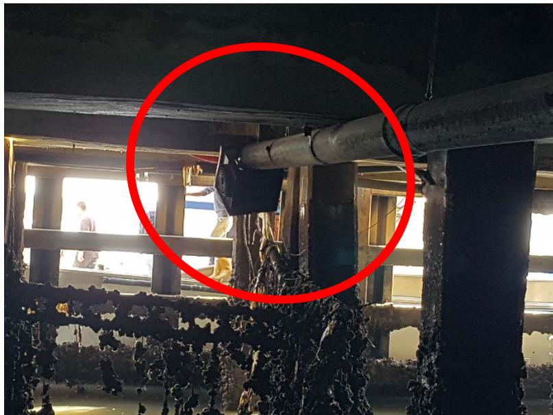
Foto 11. Arqueta de toma de muestras volcada, a la que debería de acometer el separador de hidrocarburos, que debería de estar detrás y que ya ha desaparecido
