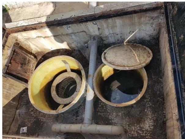
Foto 18. Vista del separador de hidrocarburos con el filtro de coalescencia en el compartimento de la izquierda
