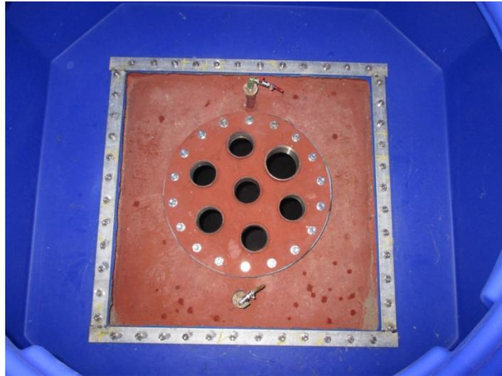
Foto nº 6. Estado final de boca de hombre prefabricada
