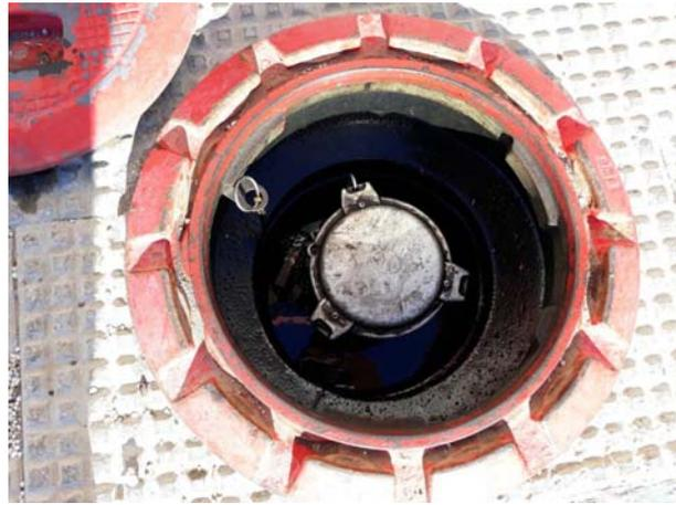
Foto nº 1. Boca de descarga desplazada existente
