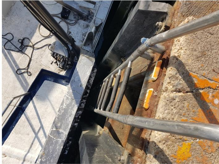
Foto nº 12. Protecciones de goma, dispuesta en el paramento vertical del agua
