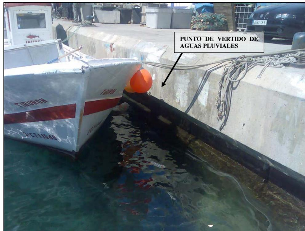
El resto de viales del puerto no están provistos de red de drenaje de aguas pluviales por lo que el agua de lluvia es evacuada en superficie hasta el mar, mediante escorrentía superficial, ya que en el puerto apenas existen superficies de tierra, salvo una zona de muelle en el dique.
